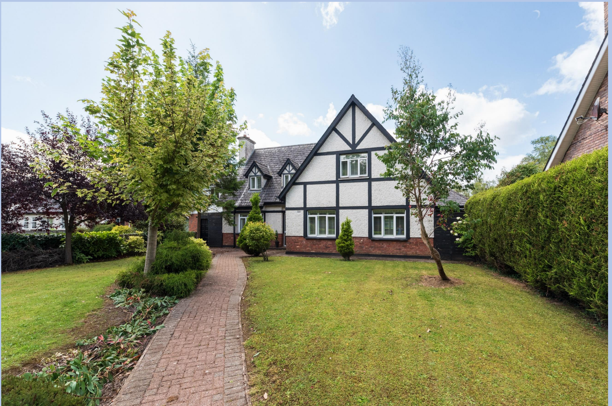
Lis na Rí, Blessington Road, Naas, Co. Kildare, W91 W2PV.
